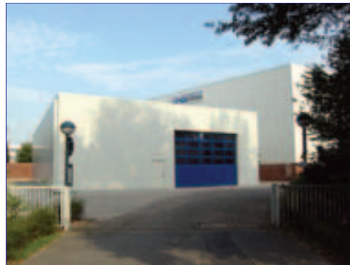
Die neue Condor-Halle auf dem Gelände bei OHB in Bremen
